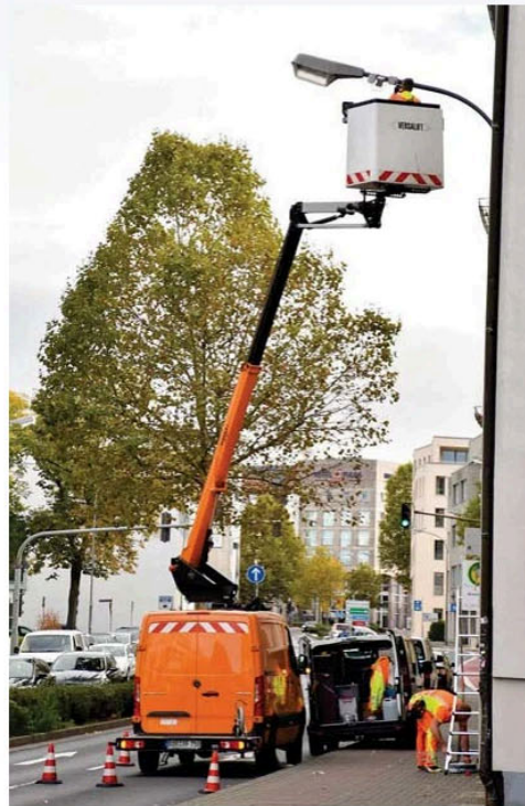
Montage der Sensoren an den bestehenden Lampen-Masten im Projektgebiet in Fulda (Foto: Stadt Fulda)
